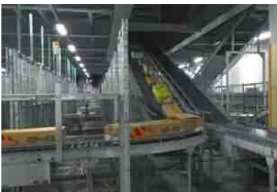
自動搬送設備
